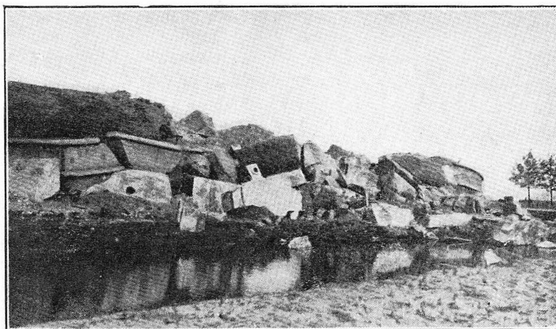
Redoute " De Smoutakker ", près de Stabroeck, détruite par les Belges.
